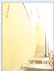
LOTTO 2: Palazzo Merlino, appartamento 1° Piano
